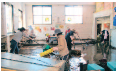
9/17・18 盛岡市災害救援VC 泥だし作業の様子
