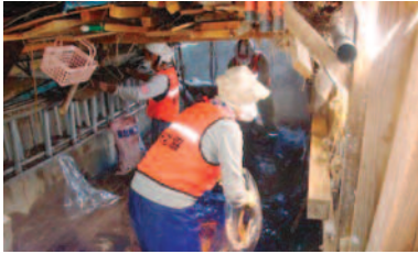
9/23 二戸市災害VC 屋内の泥撤去作業。滝沢村社協派遣ボランティア9名が浄法寺町で活動しました
