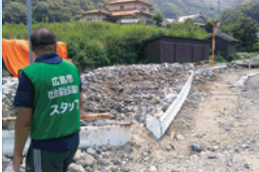
被害状況確認の様子（中野地区）
